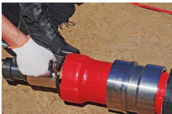
6.1.7. Произвести развальцовку трубы в два приема, повернув расширительную насадку относительно трубы после первой развальцовки на 30°. Подвижная гильза не должна находиться в зоне развальцовки. Расстояние между торцом рабочей трубы и гильзой должно составлять не менее двух длин расширительной насадки (см. рис. 22).
