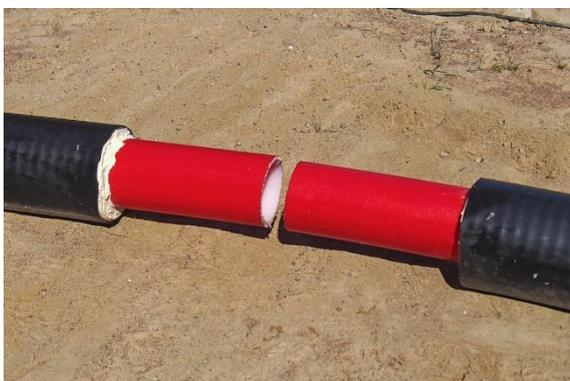
6.1.1. Снять с помощью ножа полиэтиленовую гидрозащитную оболочку на расстояние указанное в таблице 2.
