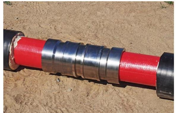
**6.2. Демонтаж соединения с подвижной гильзой.**
