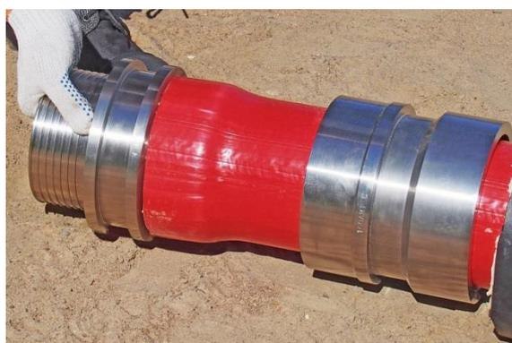
6.1.8. Вставить фитинг в развальцованную трубу. Через небольшой промежуток время труба плотно обожмет фитинг (эффект памяти формы). Запрещается вбивать фитинг в трубу и выправлять фитинг с помощью молотка.
