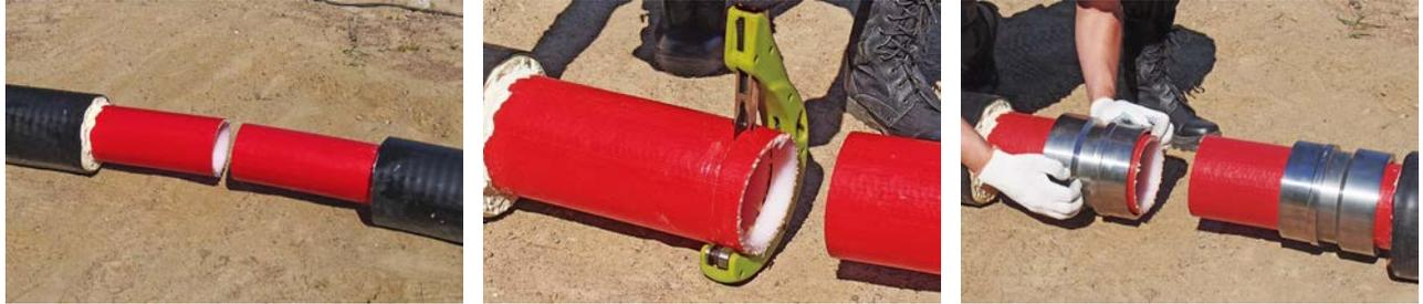
Надеть на рабочие трубы монтажные гильзы фиксирующей проточкой в сторону присоединяемой муфты. Произвести развальцовку трубы ручным или гидравлическим инструментом в два приема, повернув расширительную насадку инструмента относительно трубы после первой развальцовки на 30°.
