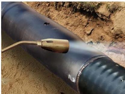
Обезжирить, зашкурить и прогреть газовой горелкой\* края оболочек труб. Нанести на них адгезивную ленту. Освободить термоусаживающуюся муфту от упаковки и надвинуть на стык. Прогреть края муфты горелкой до полной усадки на оболочку. С помощью монтажного пенопакета осуществить заливку смеси компонентов ППУ через предварительно просверленное отверстие внутрь муфты. В течение нескольких минут смесь вспенится, заполнит область стыка и затвердеет. Заварить отверстие п/э пробкой.
