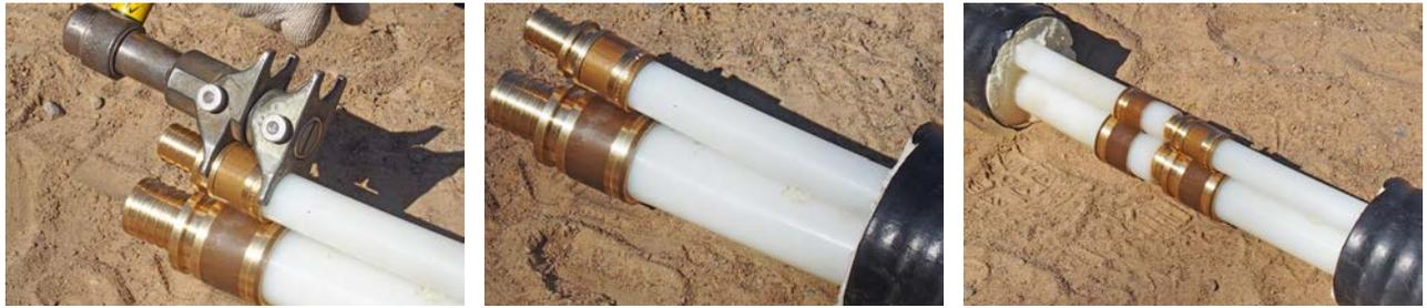
В заранее подготовленный второй отрезок трубопровода, в развальцованный торец рабочей трубы установить муфту свободным концом и повторить аналогичные действия по запрессовке второй гильзы для нее. Готовое соединение трубопроводов абсолютно надежно и герметично.
