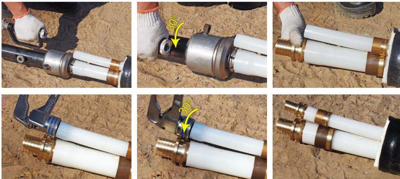
Вставить соединительную муфту в развальцованную трубу. Через небольшой промежуток времени труба плотно обожмет муфту.
