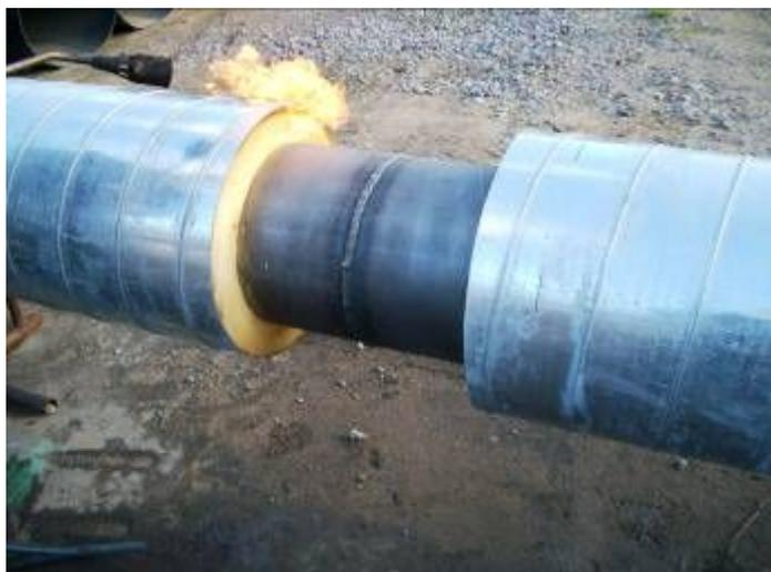
Прогреть края оцинкованной оболочки труб, образующих стык, мягким пламенем горелки до температуры  $+80^{\circ}\text{C}$  –  $+90^{\circ}\text{C}$ . Температуру прогреваемых
