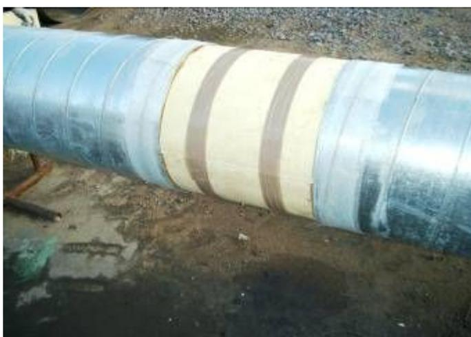
Установку металлического кожуха произвести таким образом, чтобы нахлест краёв кожуха был ориентирован сверху вниз. Кожух устанавливается симметрично относительно центра
