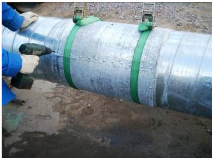
Скрепить кожух в зоне нахлеста винтами-саморезами или заклепками по всей длине через каждые 80-100 мм. Расстояние от края нахлеста – 10-15 мм. Края кожуха также крепятся к оцинкованной оболочке винтами-саморезами или заклепками по
