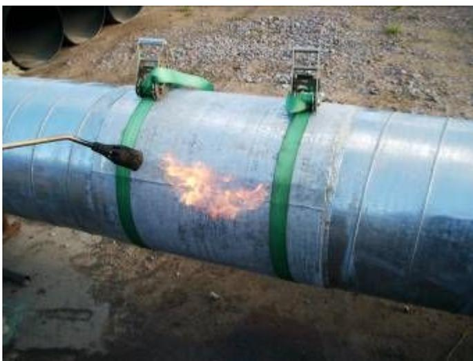
Прогревая мягким пламенем газовой горелки зоны установки адгезивной ленты, постепенно произвести окончательную затяжку стяжных ремней. Критерием полного прогрева и расплавления адгезивного материала являются следующие внешние признаки:
