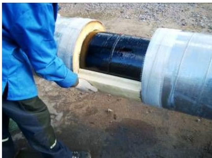
Замерить ширину неизолированной части между торцами заводской изоляции. Ножовкой отрезать две полускорлупы нужного размера (не допускать наличия зазора между полускорлупами и торцами заводской изоляции). Выбрать у полускорлуп канавку под сварной шов. После высыхания мастики установить две полускорлупы на стык и зафиксировать их скотчем.
