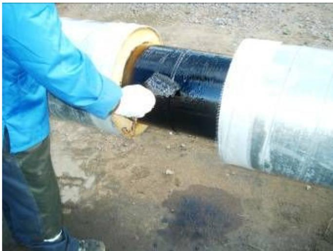
На поверхность стальной трубы нанести антикоррозионное покрытие. Перед нанесением антикоррозионного покрытия материал (мастику МБР-ОС-Х-150) следует тщательно перемешать. Фильтрование мастики не допускается. Мастика на поверхность
