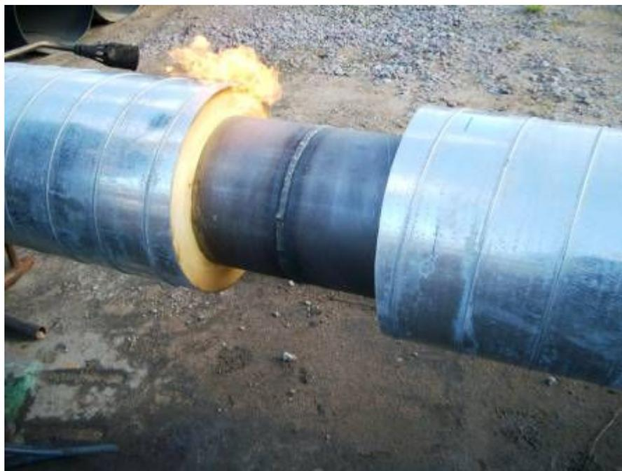
Прогреть края оцинкованной оболочки труб, образующих стык, мягким пламенем горелки до температуры  $+80^{\circ}\text{C}$  –  $+90^{\circ}\text{C}$ . Температуру прогреваемых поверхностей контролировать адгезивной лентой, прикладывая ее к прогреваемой поверхности, при плавлении прогрев считать достаточным. Контроль прогрева производить в произвольных точках, но с обязательным контролем нижних и боковых поверхностей.
