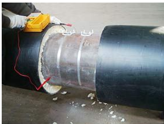
А.2. Последовательность соединения сигнальных проводов.
